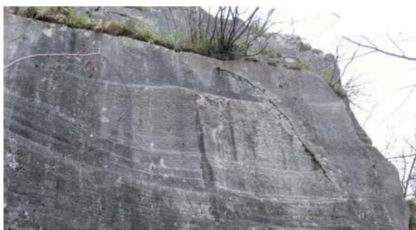
Figura 1 – Scavo in trincea: Cuneo, Trincea, Pelo (a sinistra); tracce di lavorazione (a destra)
