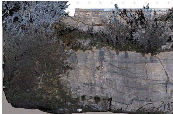
Figura 6 – Dettaglio della restituzione grafica finale: l'elaborato integra l'immagine della scansione 3D con la vettorializzazione delle principali discontinuità e tracce di lavorazione
