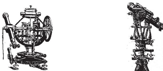
Figura 1 – teodolite di Reichembach e tacheometro a cerchi nascosti (cleps) di Porro
