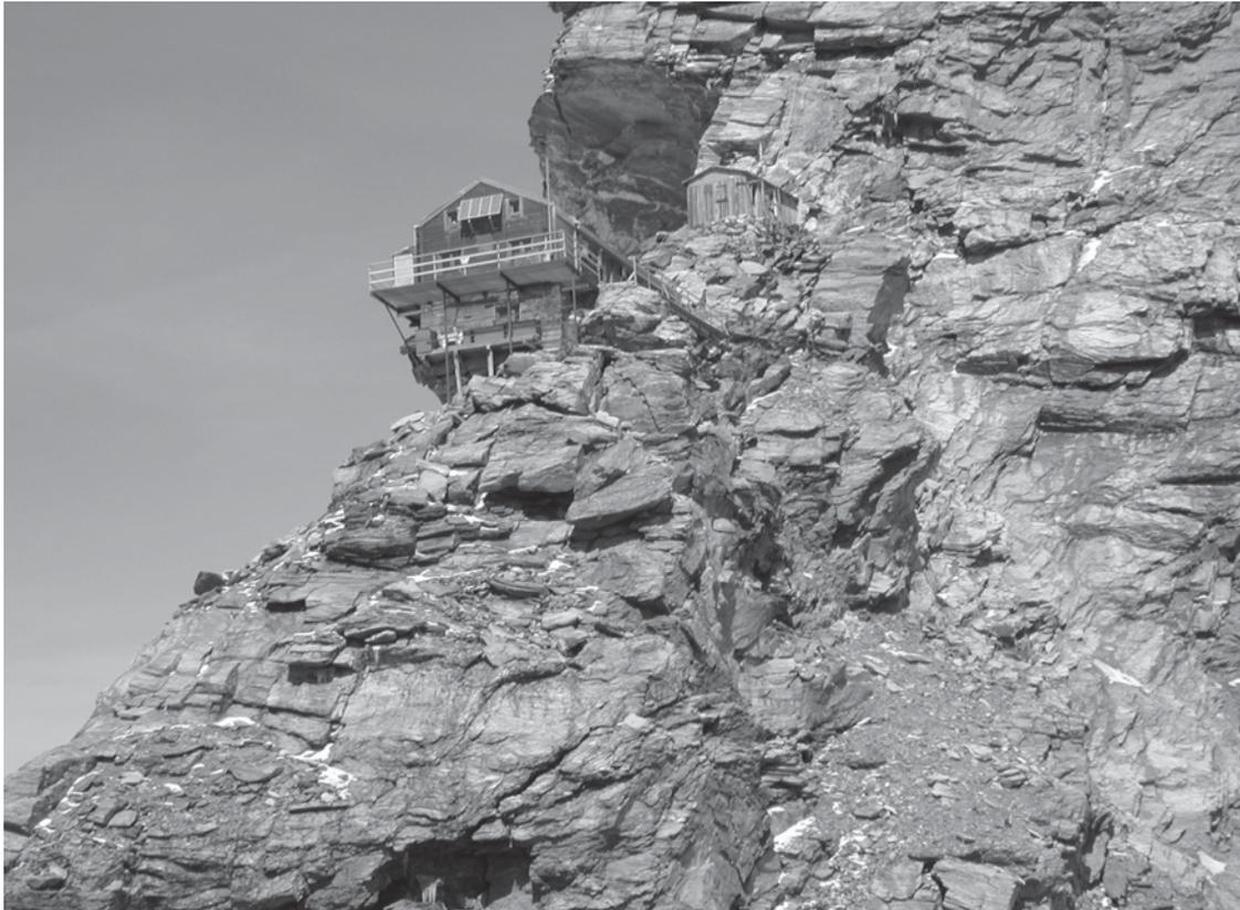
*Figura 1 - Capanna Carrel lungo la cresta occidentale del Cervino. E' ben evidente lo stato di elevata fratturazione dell'ammasso roccioso su cui poggia la struttura (Foto Regione Autonoma Valle d'Aosta).*
