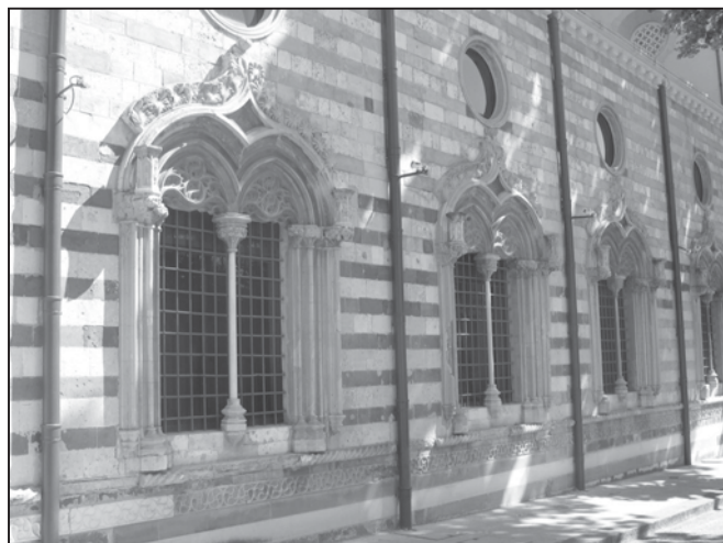
Figura 2 - finestre in stile gotico-catalano (prospetto Sud-Est)
