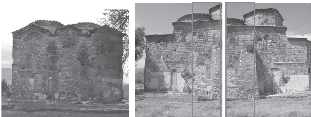
Figure 3,4 – riprese ortogonali dei prospetti ovest e sud
