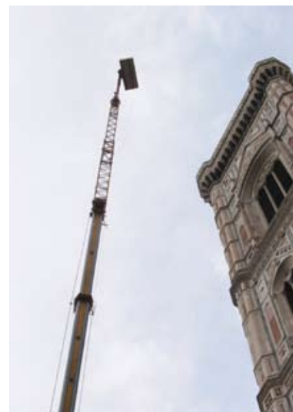
Figura 2 - Realizzazione delle prese fotogrammetriche
