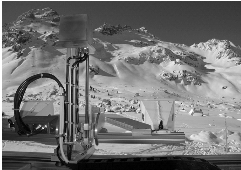
Figura 5 installazione radar presso Lizum in Austria
