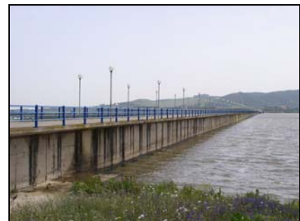
Figura 1 – Diga sul Rio Cixerri (CA)
