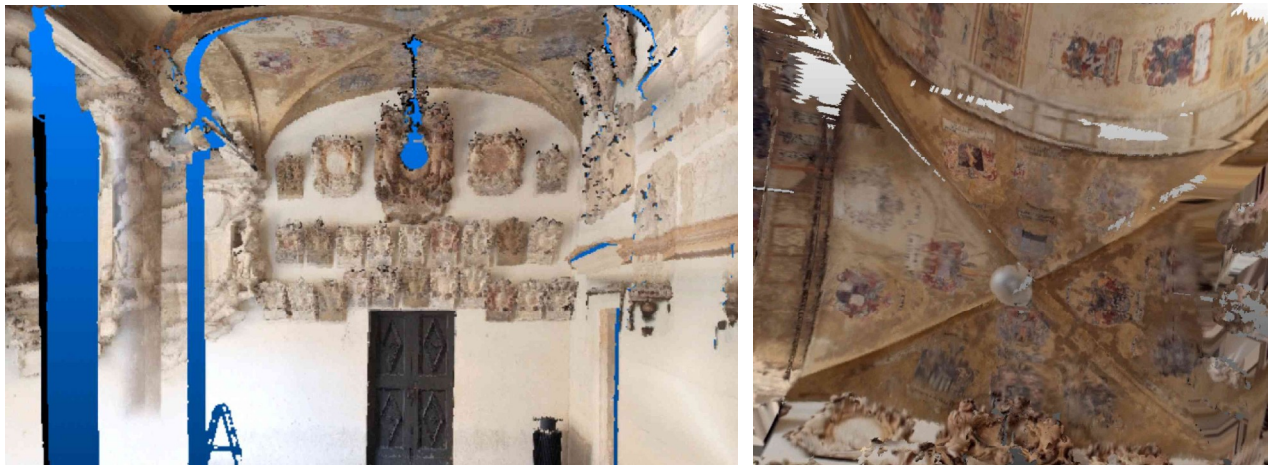
Figura 3 – Esempi della texture ottenuta con il software Reconstructor©: prospetto Est (sx); volta a crociera (dx)
