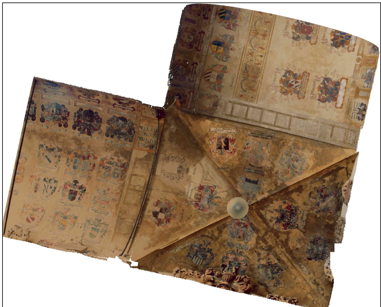
Figura 5 – Texture della volta a crociera ottenuta in ambiente Z-Map © con la mosaicatura di più immagini a livelli uniformati
