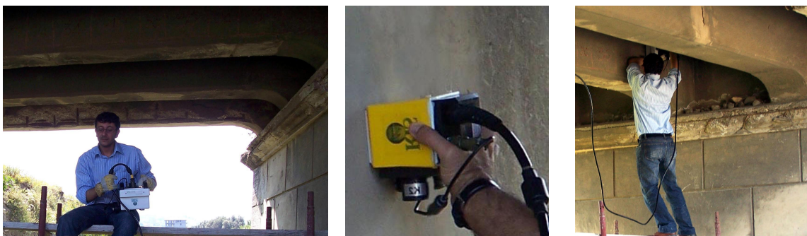
Figg. 5 – Antenne utilizzate (900 mhz e 2 ghz) e indagine su una trave
