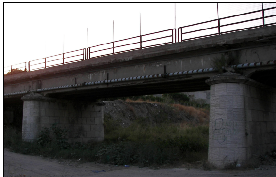
Fig. 1: Vista del ponte
