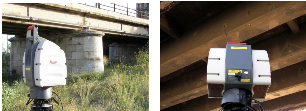
Figg. 2: Viste di alcune stazioni realizzate per le scansioni e dei targets utilizzati
