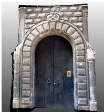
Figura 5 - Superficie mappata ottenuta con il software JRC Reconstructor.
