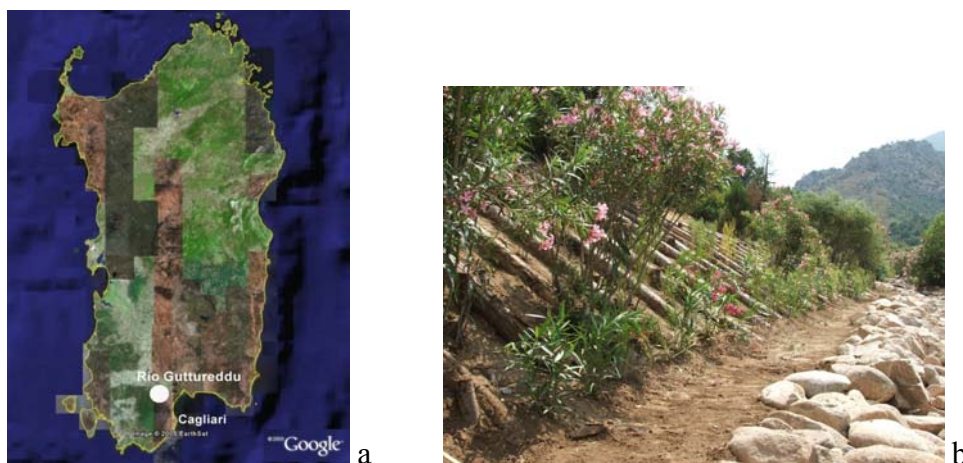
Figura 1 – a) Il caso di studio italiano del progetto PROGECO: Regione Sardegna, rio Gutturreddu; b) Palificata viva di sostegno realizzata sulla sponda del rio Gutturreddu.
