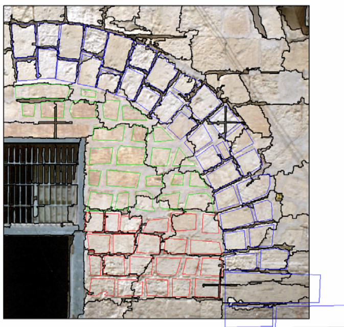
Figura 5 – Fotopiano di muratura nel bastione di Floriana, Malta: esempio di segmentazione con un certo set di parametri (colore 0.3, compattezza 1.0) e valutazione dei risultati su tre zone diverse, riconoscibili dal colore di una schematica vettorializzazione manuale. I grafici (a) e (b) confermano come, al crescere del fattore di scala, la sola zona 1 (blu) fornisca risultati abbastanza buoni.
