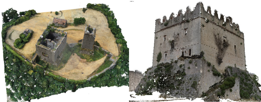
Fig. 1. Viste del modello 3D finale del Castello e della Torre ottenuto con i dati fotogrammetrici.
