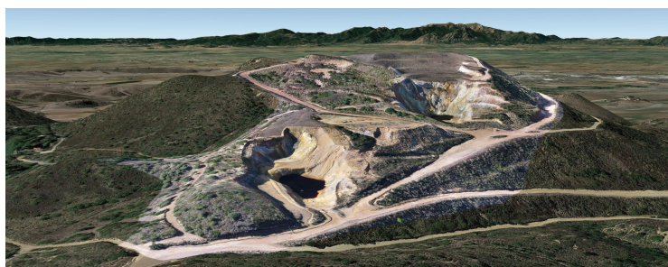
Fig. 2. Cantiere minerario di Santu Miali . Ricostruzione del modello digitale del terreno e sovrapposizione con la piattaforma Google Earth ®.
