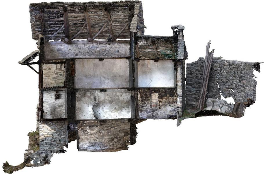
Fig. 7. Sezione della nuvola di punti fotogrammetrica (edificio principale).
