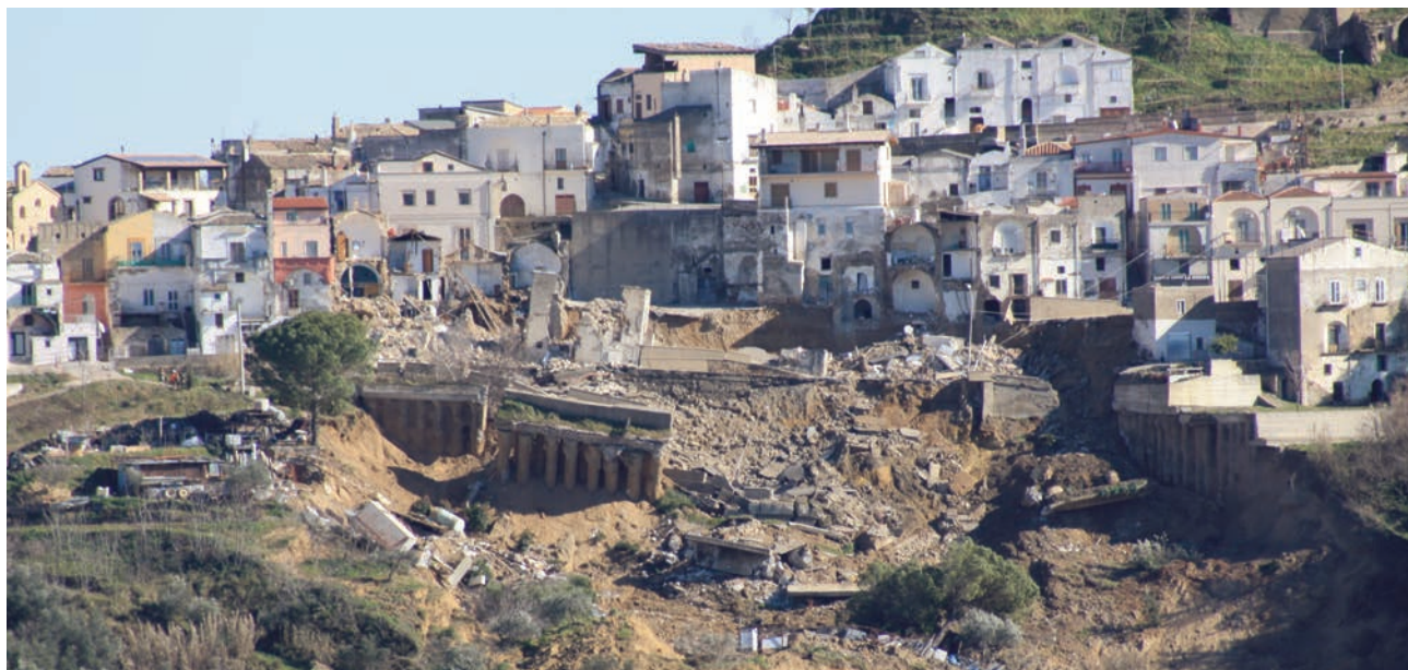
Figura 1 – Vista del fronte di frana di Pomarico (MT) due giorni dopo l'evento franoso. Son visibili i detriti derivanti dai crolli degli edifici e del piano stradale.
