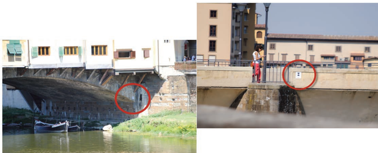
Figura 4 - Target plastificati posizionati sull'arcata di P.te Vecchio e sulla spalletta del P.te alle Grazie.
