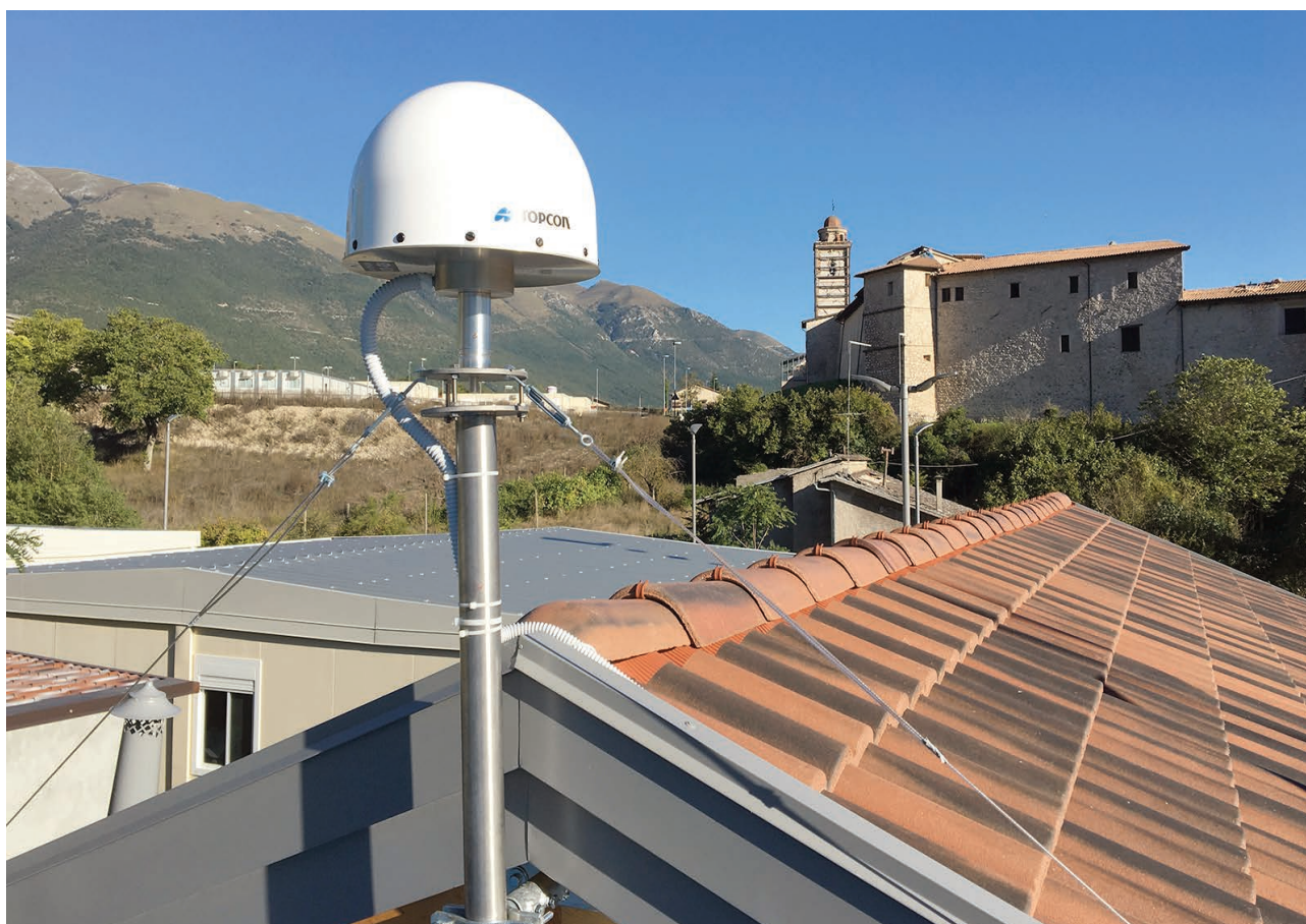
Fig. 2 – La nuova stazione di Norcia (PG)
