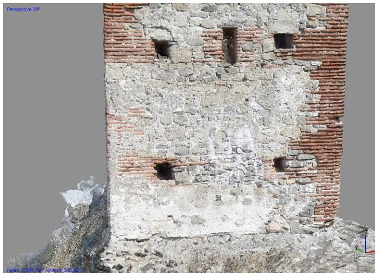
Figura 2 – Particolare del modello 3D (lato Sud-Ovest) con Texture, sw Agisoft PhotoScan.
