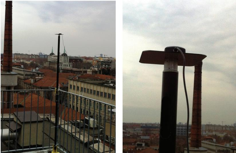
Figura 2 - Installazione dell'antenna ANN-MS del ricevitore u-blox EVK-6T sul tetto dell'edificio Nave (a sinistra) e dettaglio della basetta metallica usata come sostegno per il fissaggio dell'antenna (a destra).
