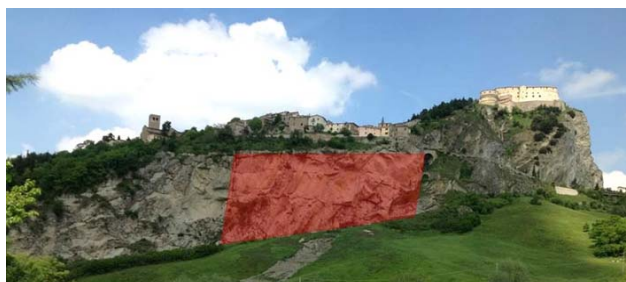
Figura 4 - Porzione di parete Sud utilizzata per analisi geologiche.
