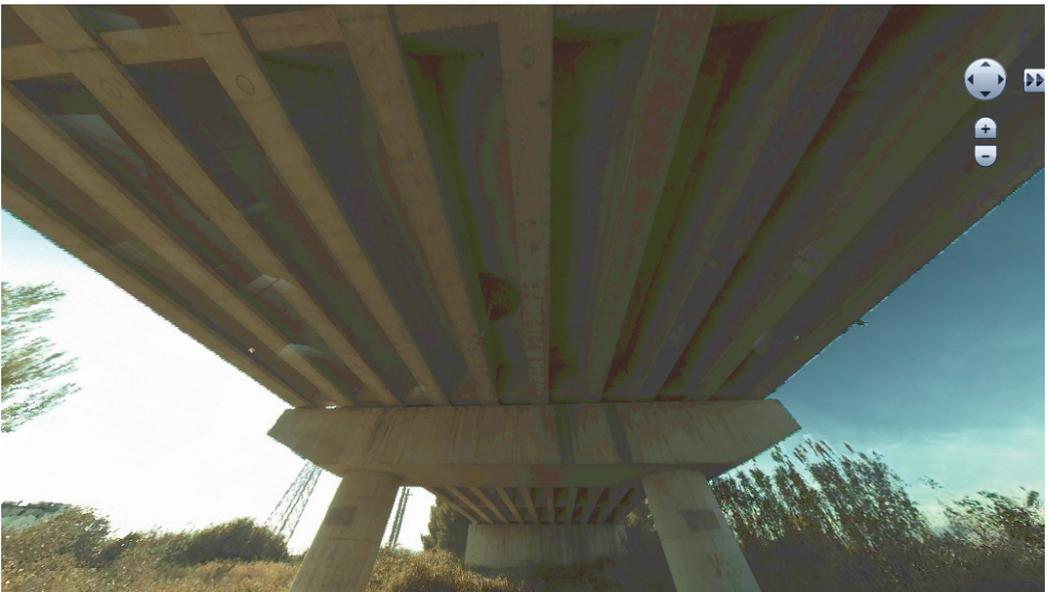
*Figura 3 - Zone di degrado all'intradosso del ponte al km 412+587 della SS 106 jonica.*
