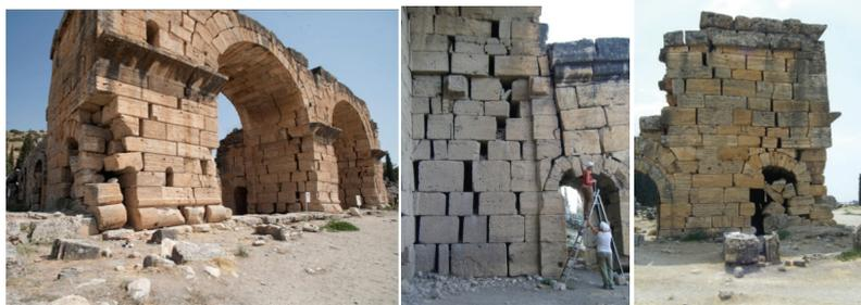
Figura 1 - Alcuni esempi degli imponenti dissesti delle murature e delle volte delle Terme-chiesa.
