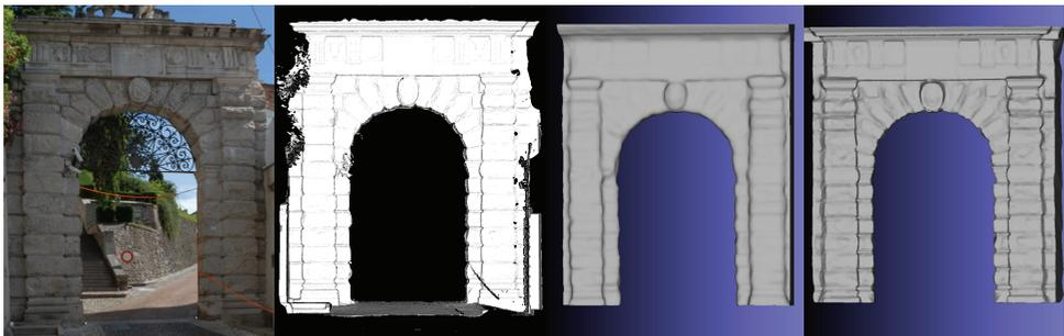
Figura 1 - L'Arco Bollani di Udine e i DSM prodotti con RiSCAN, MeshLab e Geomagic da scansioni TLS.
