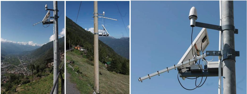
*Figura 10 – (a, b) installazione di due ricevitori su supporti pre-esistenti (pali dell'illuminazione pubblica e linea a bassa tensione). (c) Dettaglio di una installazione.*
