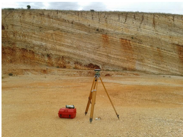
Figura 1 – Parete rocciosa sub-verticale e strumentazione GNSS.
