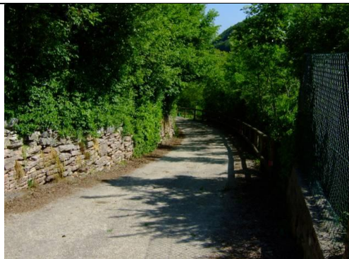
Figura 9. Vecchio muro in sassi.
