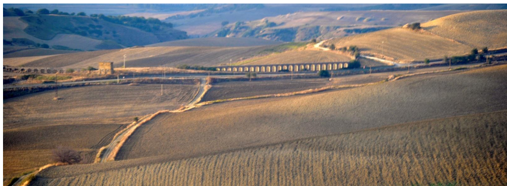
Fig. 4. Le arcate del lungo acquedotto antico che emergono a ridosso della SS Aurelia bis caratterizzano il paesaggio e lo spazio agricolo odierni (Foto A. D'Ascenzo, 2011; volo GREAL).
