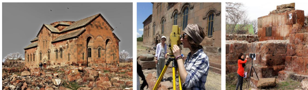
Figura 2. Le attività di rilievo topografico e laser scanning .
