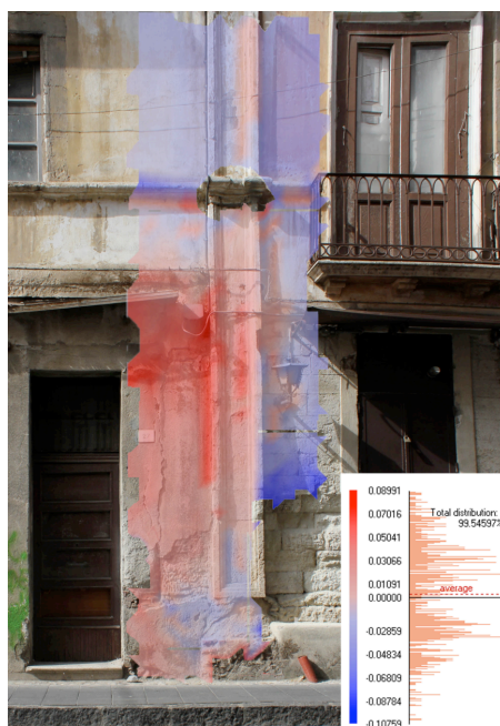
Figura 9. Rigonfiamento in facciata.
