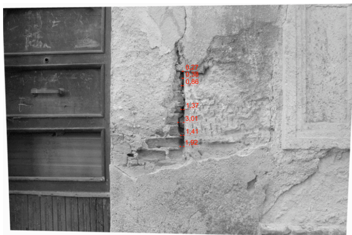
Figura 8. Dimensioni di una lesione in cm su fotoraddrizzamento.
