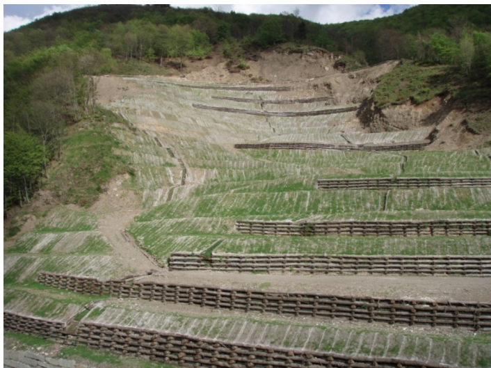
Figura 4. Intervento strutturale a seguito di una frana che nel 2010 ha interrotto per alcuni giorni la SS 632 – loc. Pracchia (PT)
