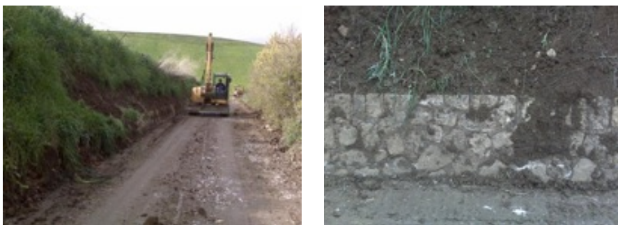
Figura 12. Tracciamento e recupero della sede e ripristino dei manufatti.
