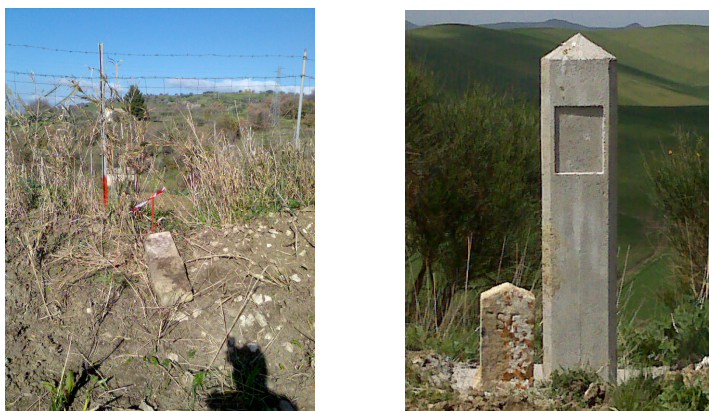
Figura 14. Esempio di materializzazione di vertice di confine.
