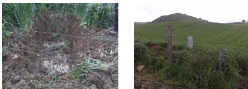
Figura 13. Esempio di materializzazione di vertice di confine.
