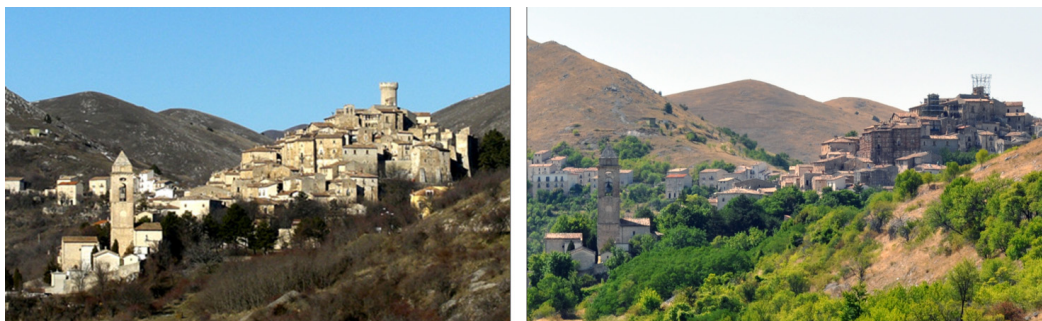
Figura 3. Viste del borgo di S. Stefano prima del sisma e allo stato attuale; si nota l'esile riproposizione volumetrica della torre tramite tubolari metallici.
