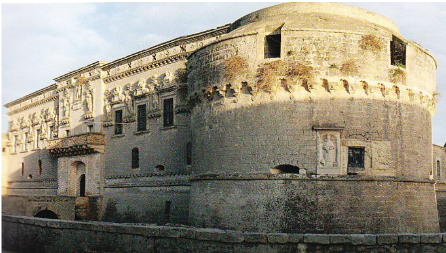
Figura 4. Castello di Corigliano d'Otranto con la facciata barocca.
