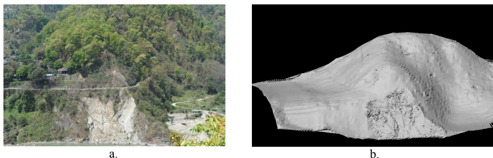
Figura 2 – Una delle zone di imbocco in prossimità di Rangpo: 2.a (a sinistra) una delle immagini utilizzate per ricostruire il DSM; 2.b (a destra) il modello digitale del terreno restituito.
