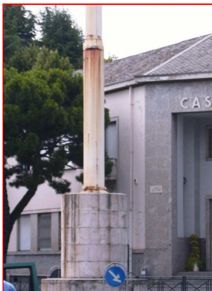
Figura 7 – La struttura metallica realizzata dalla Dalmine, con il suo basamento.
