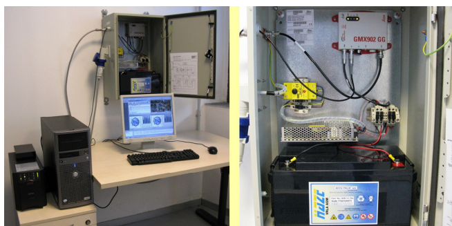
Figura 3 – Server del sistema e ricevitore satellitare della stazione Master.
