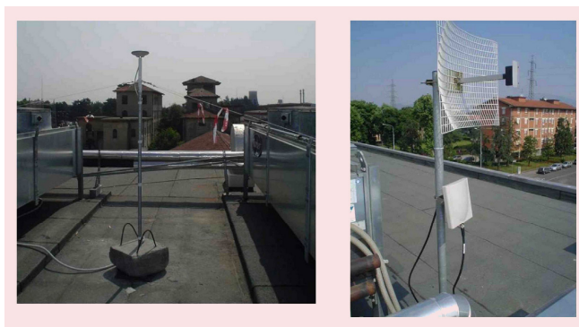
Figura 2 – Antenna di ricezione GNSS (a sinistra) e di comunicazione Wlan (a destra).
