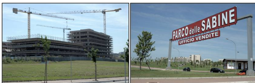
Figura 12 – Parco delle Sabine, 2010. Zone in costruzione. Foto di Andrea Di Somma.
