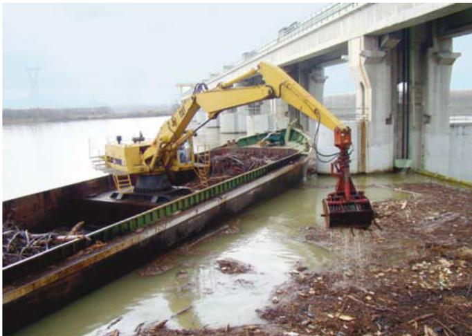
Figura 5 – Esempio di deposito eterogeneo presso il ponte S. Nazario.
