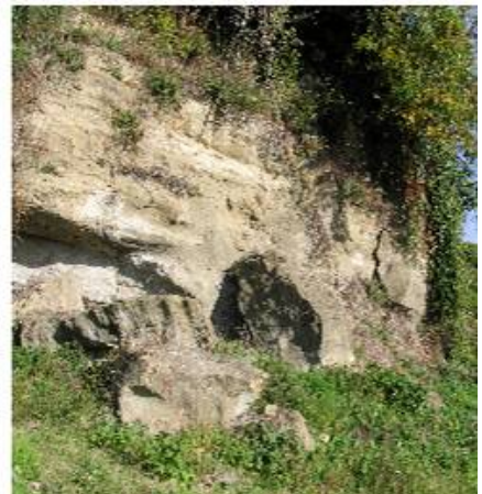
Figura 3 – Particolare del distacco dei blocchi.
