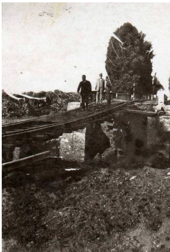
Figura 1 – Immagine risalente all'anno 1929 che mostra gli effetti di una violenta ondata di piena del Rio Cixerri sulla linea ferroviaria Iglesias-Cagliari nella località Sa Mitza in comune di Siliqua.
